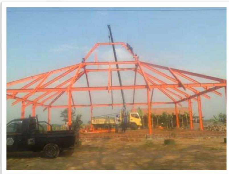
**KONSTRUKSI BAJA UK. 19 M X 36 M
