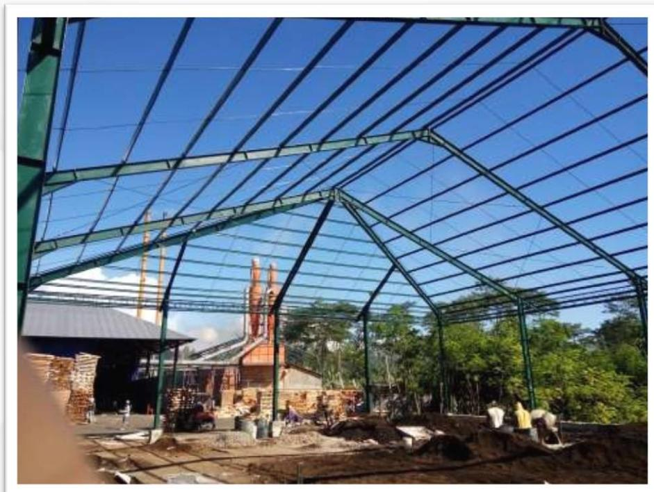
**KONSTRUKSI BAJA UK. 23 M X 50 M
