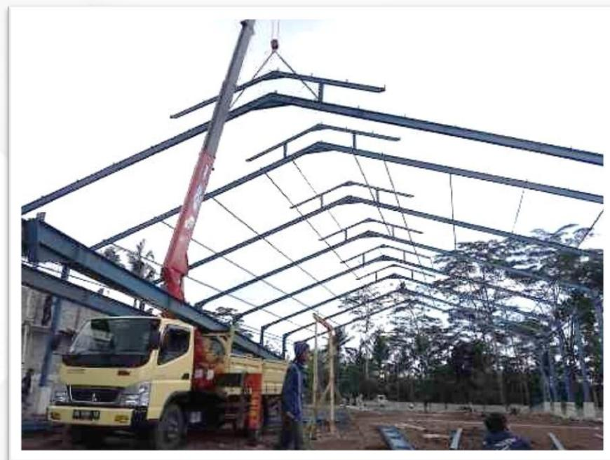
**KONSTRUKSI BAJA UK. 25 M X 78 M
