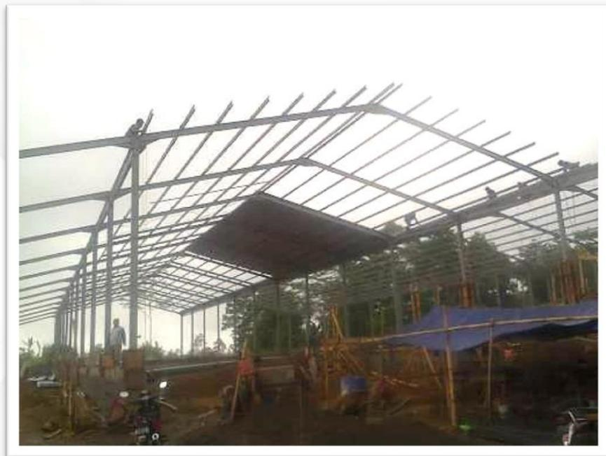
**KONSTRUKSI BAJA UK. 16 M X 66 x 2 UNIT
